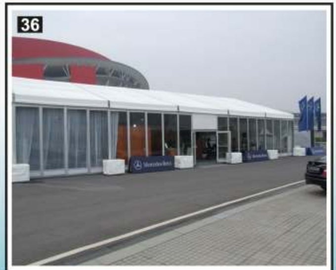
خيام لا تتطلب ارضيات محددة حيث يمكن تركيبات فوق العشب (الاسفلت والأسمنت)
